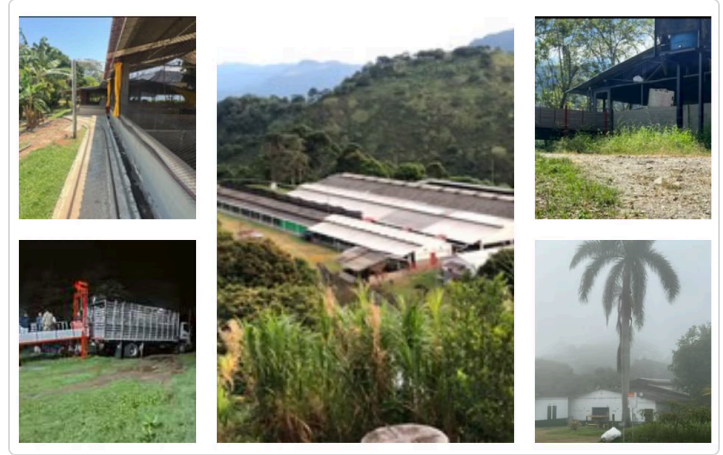
Figura 2. Registro fotográfico de las instalaciones y operaciones en Granja Montana. Fuente: Propia.
