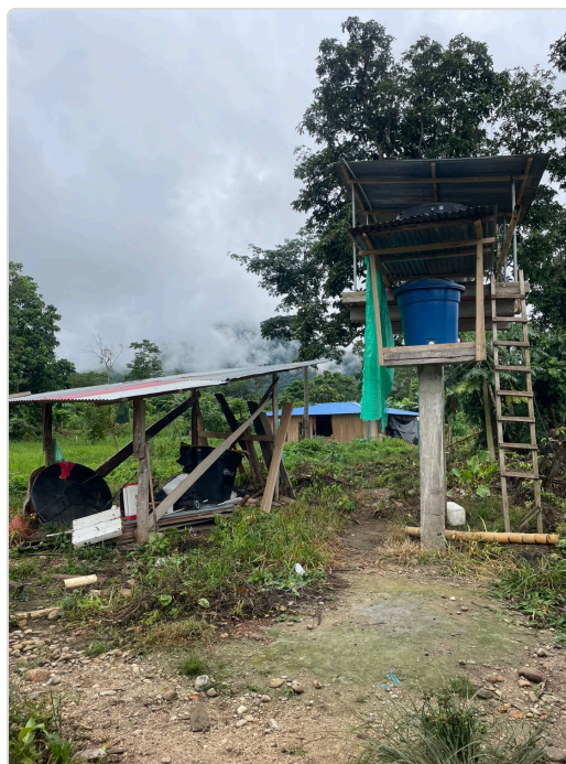
Figura 3. Tanque elevado para suministro del agua mediante gravedad Granja Huevos el Trébol.
