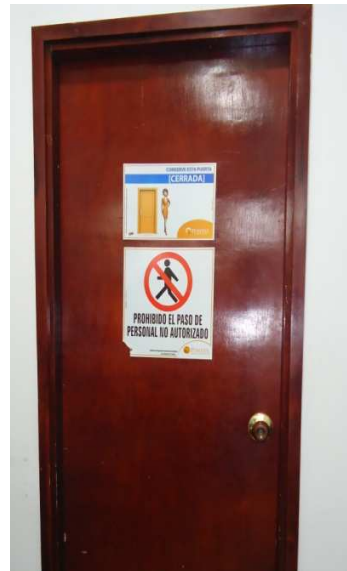
Figura 10. Falta de un sistema de control de acceso.
