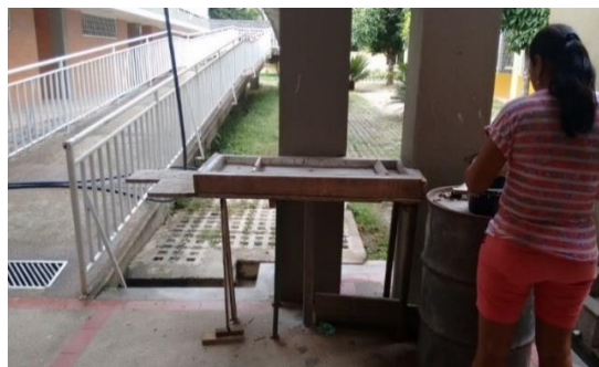
Figura 8. Bebedero en construcción en la ITE Martín Pomala
