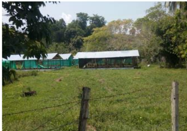
Figura 25. Galpones que contaminan la bocatoma
