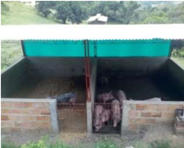
Figura 25. Instalaciones para primerizas y machos
