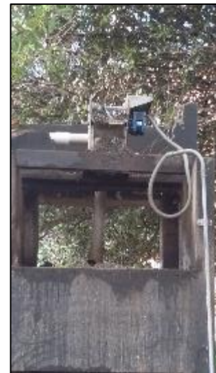
c) Distribución uniforme del agua en la malla filtrante.
