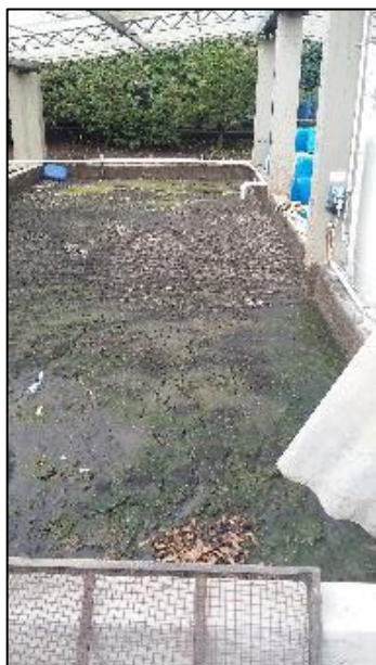
a) Celda 1 (lecho de secado)
