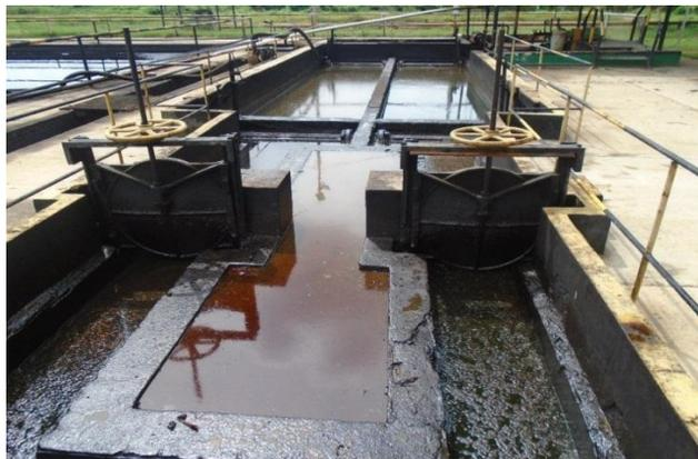
**Figura 29** Sistema de Compuertas Separador API
