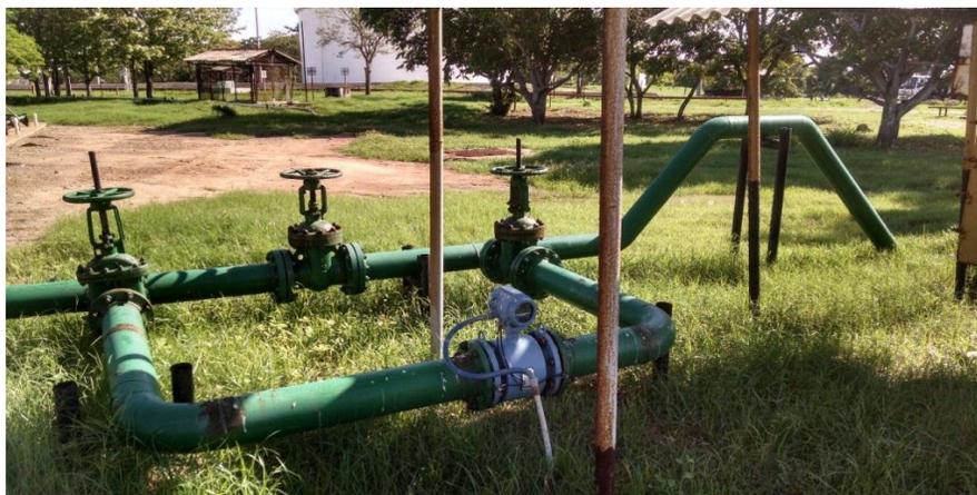
**Figura 36** Nodo 5, Medidor de Vertimiento
