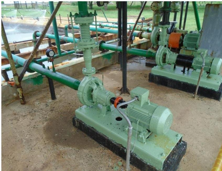
**Figura 41** Bombas de vertimiento, sistema ARI. Estación Cicuco
