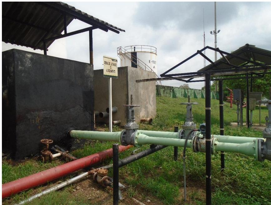
**Figura 27** Nodo 1: Registro Tanques de Almacenamiento y Medidor de Drenaje
