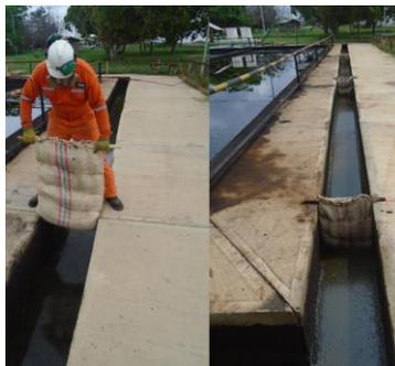
**Figura 40** Instalación de Filtros
