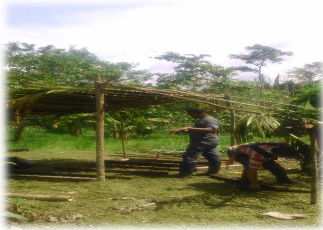
Foto 5. Construcción de Vivero
