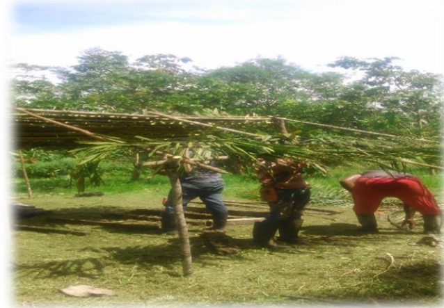
Foto 6. Construcción de Vivero
