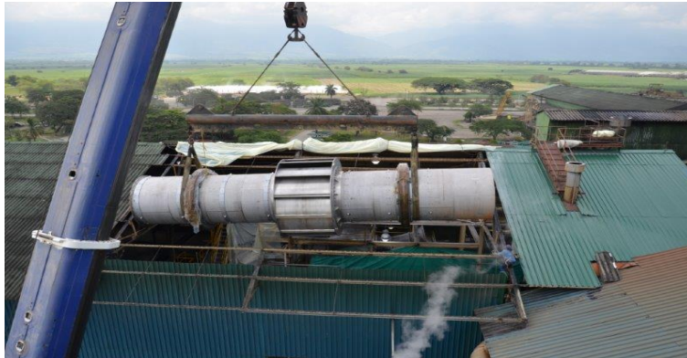
Figura 2 Instalación de la secadora-enfriadora con grúa de elevación
