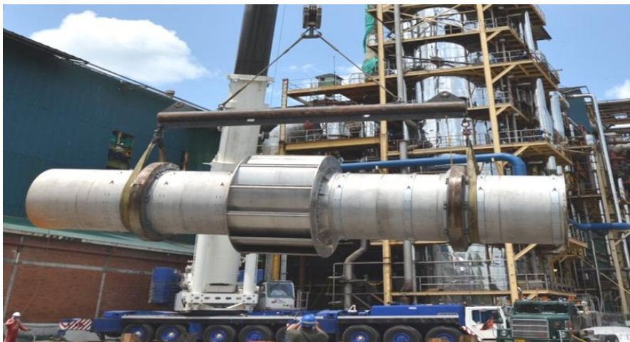
Figura 7 Montaje tambor secadora-enfriadora
