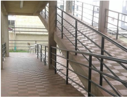
Rampas de acceso a los diferentes pisos del edificio
