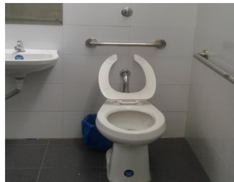
Baños adecuados para personas en sillas de ruedas
