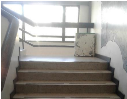
Acceso a Edificio de Laboratorios e Idiomas
