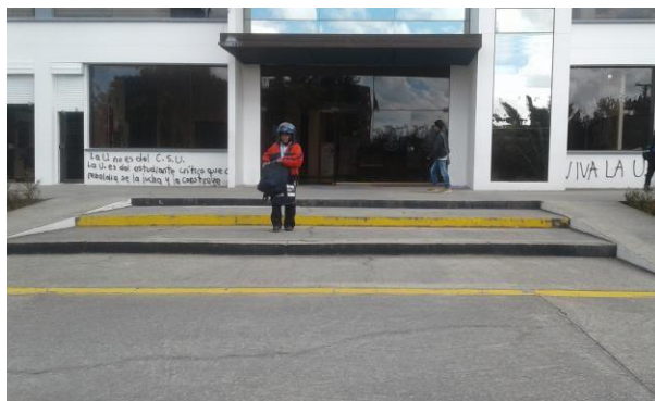
Rampas de Acceso al edificio Administrativo
