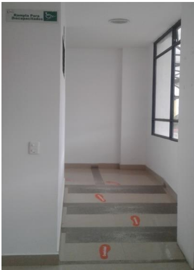
Rampa para discapacitados
