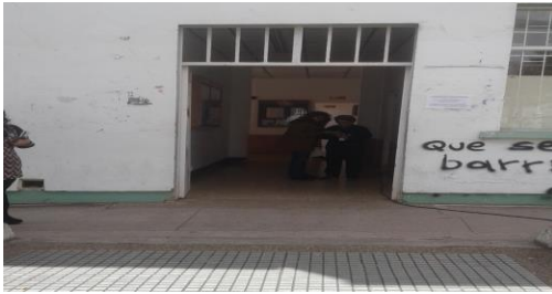
Facil acceso por ser un solo piso
