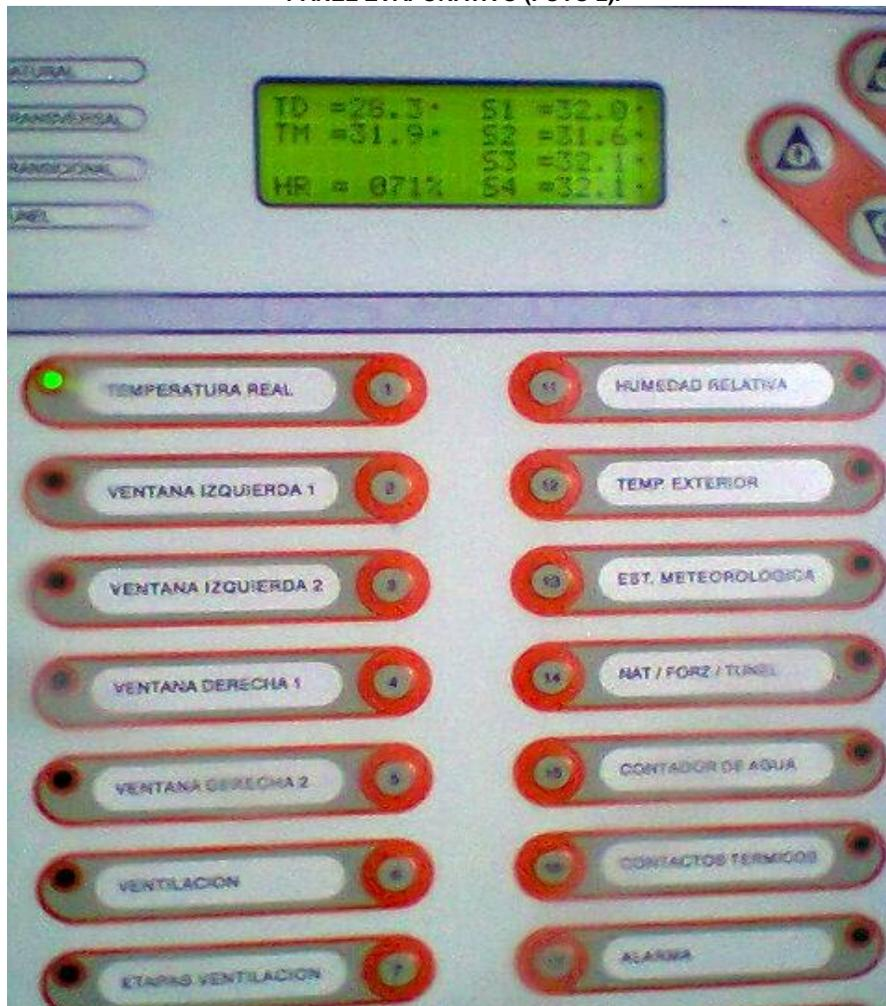
PÁNEL DE CONTROL (AUTOMATIZADOR QUE GENERA LAS ÓRDENES QUE CONTROLAN EQUIPOS DE SENSORES Y ENCIENDEN LOS SISTEMAS DE CONTROL DEL MICRO AMBIENTE DEL TÚNEL)
