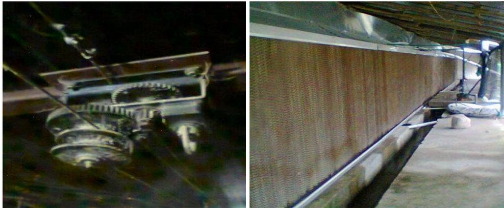
SISTEMA MANUAL DE POLEAS (PARA EL CASO DE LAS CORTINAS ES AUTOMÁTICO / MANUAL) QUE PERMITE MODERAR LA ALTURA DE LAS LÍNEAS DE BEBEDEROS Y COMEDEROS (FOTO 1), SISTEMA DE PÁNEL EVAPORATIVO (FOTO 2).
