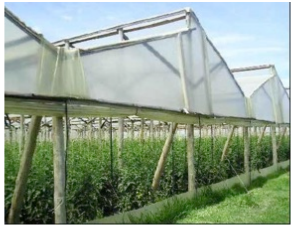
Figura 6 Invernadero Tipo Capilla
