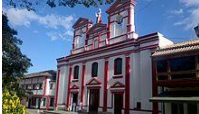
Figura 8 - Plaza central e iglesia de pacho -. Fuente: (Alcaldía Municipal de Pacho, Cundinamarca, 2017)
