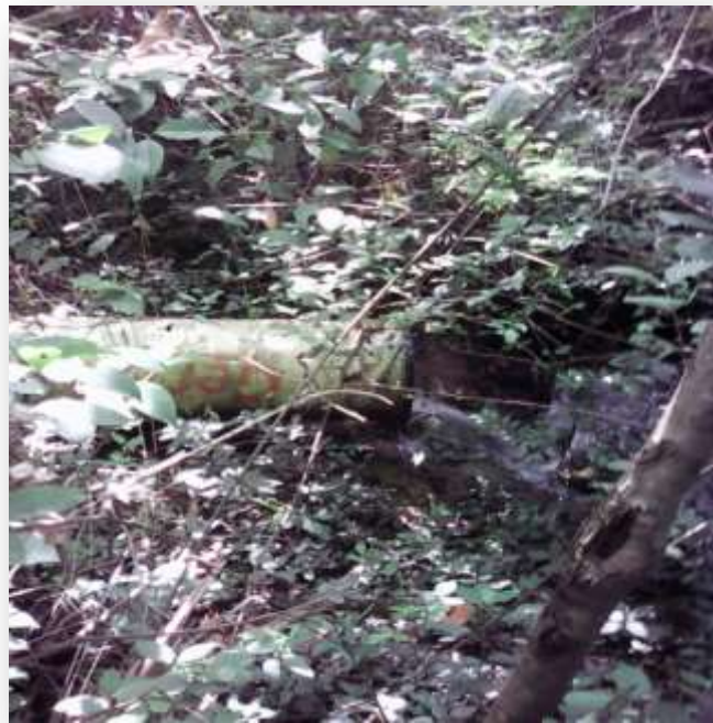
Foto 4. Desembocadura de Alcantarillado Municipal.
