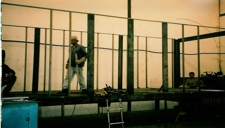
Foto 4. Ensamble de paneles de las paredes.
