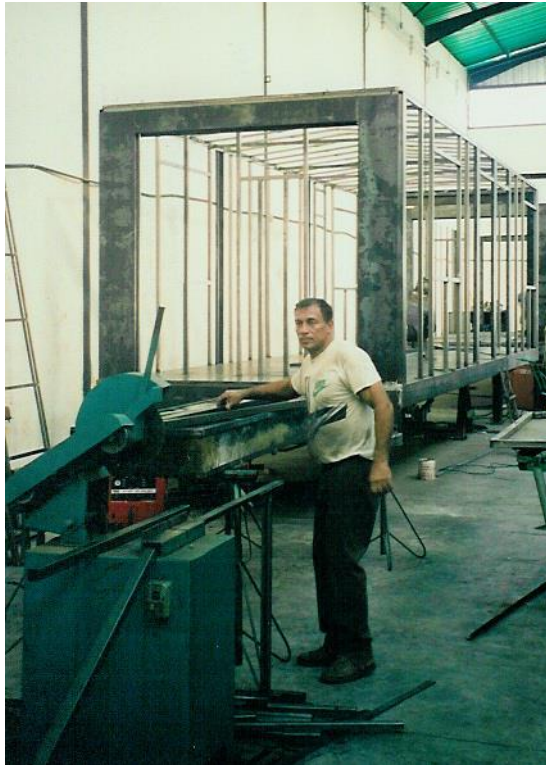
Foto 3. Proceso de perfilado para el armado de la carrocería.
