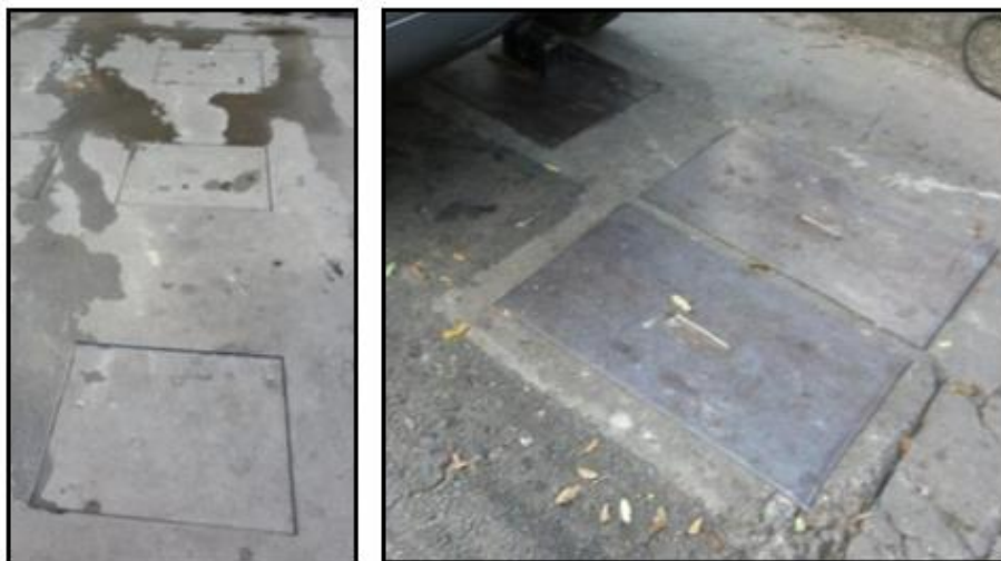
FIGURA 3 DETALLE TRAMPA DE GRASA
