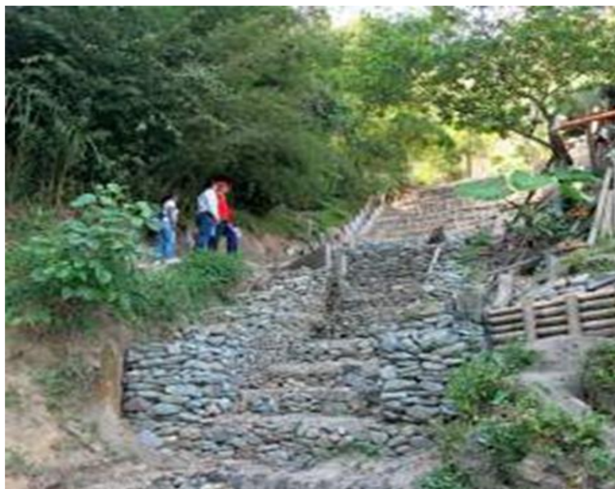
Obras de mitigación realizadas en el barrio Jazmín de Ibagué. FOTO CORTESÍA COLOMBIA HUMANITARIA
