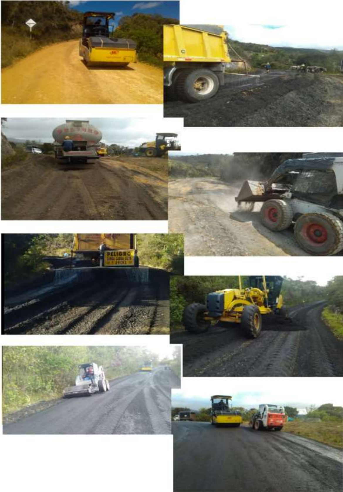
Figura 25. Aspecto del manejo de los materiales en obra.
