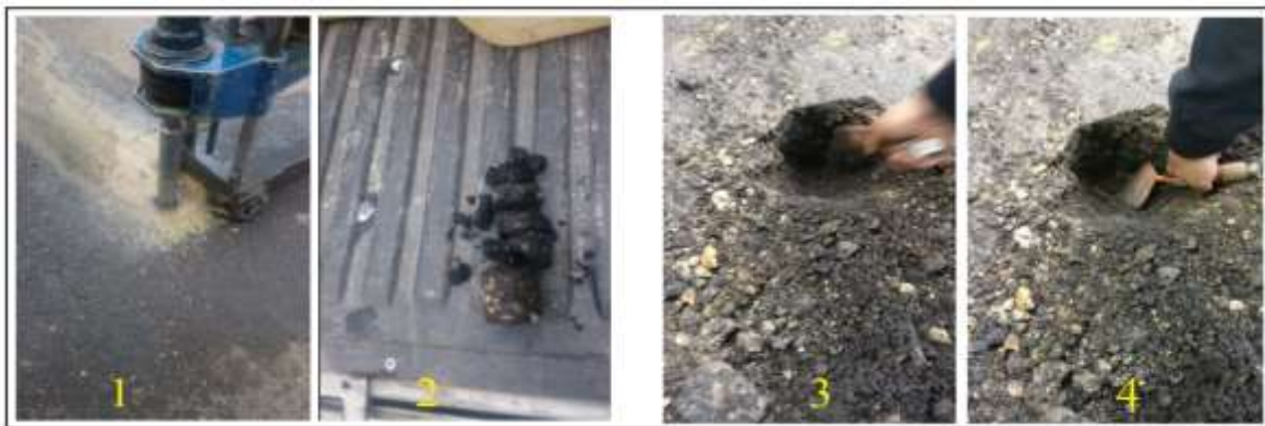
Figura 18. Aspecto de las mezclas instaladas por el contratista de obra.
