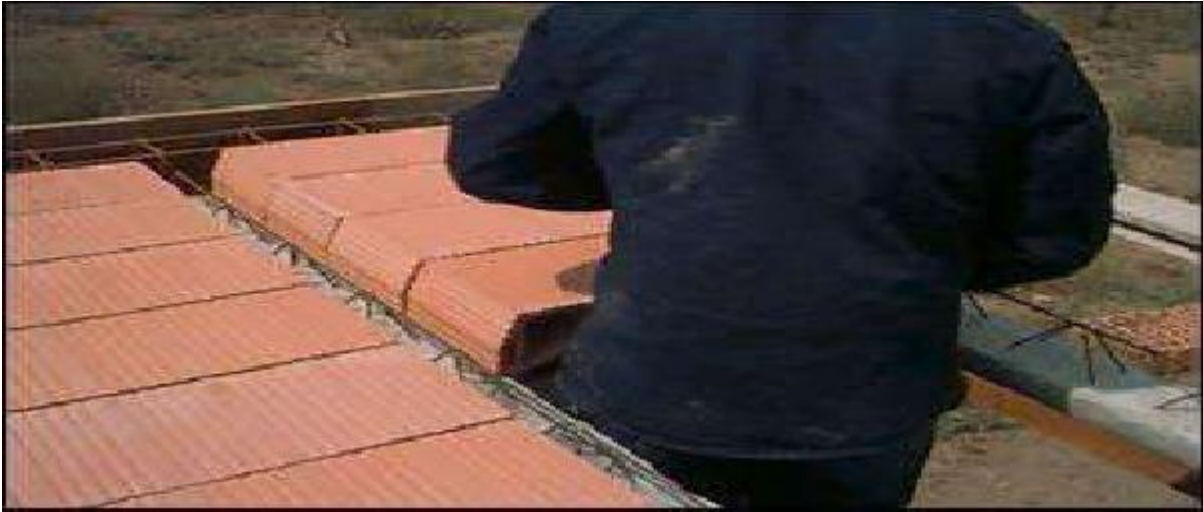
Figura 48. Colocado del bloquelón en plancha
