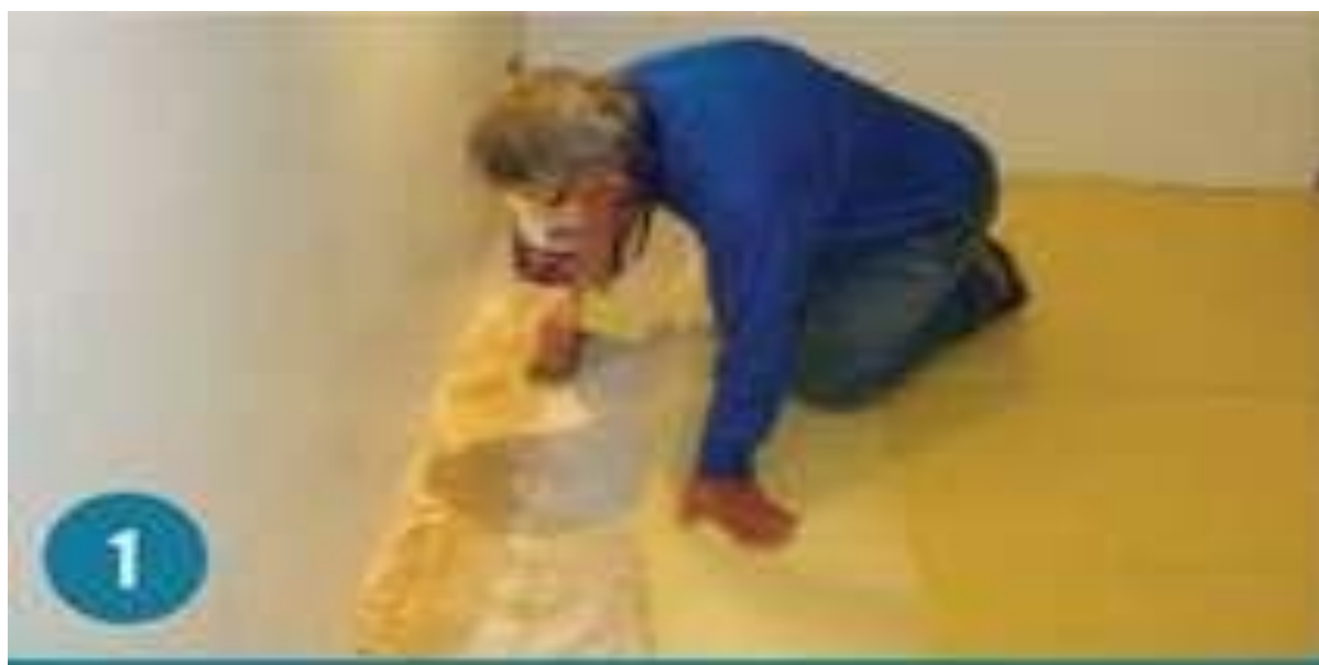
Figura 55. Colocado de piso flotante
