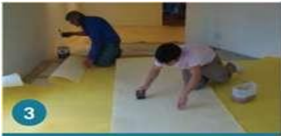
Figura 56. Colocado final del piso
