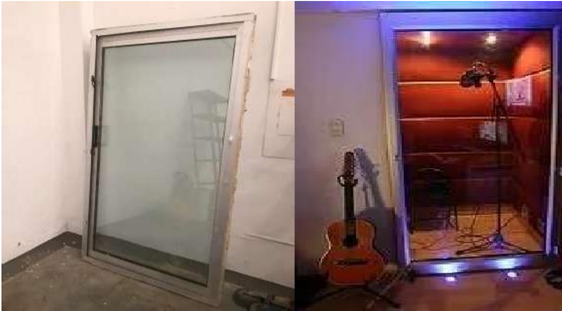
Figura 59. Puerta acústica en vidrio
