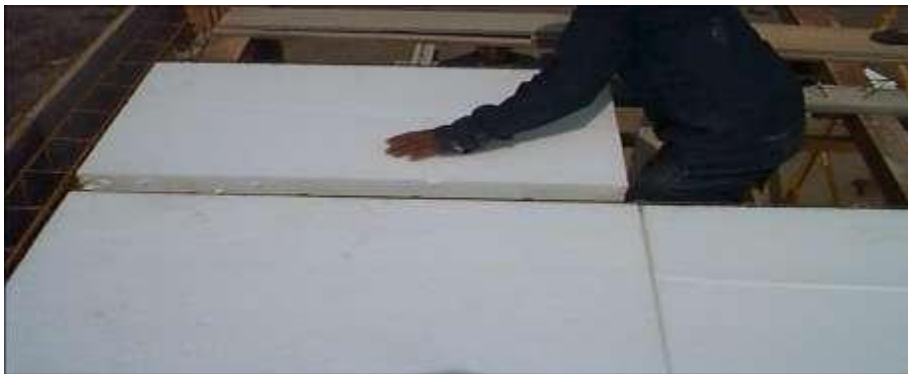
Figura 49. Colocado de material aislante
