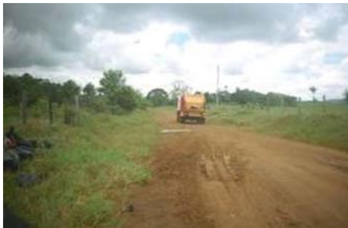
Figura 22. Vía hacia Monforth la cual conduce al sitio de disposición final actual. Fuente: CDA, 2007
