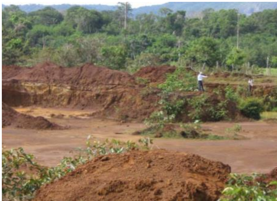
Figura 21. Sitio de instalación y adecuación del lleno sanitario. Fuente: CDA: 2011
