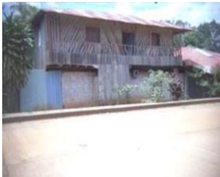
Figura 19. Estado actual de las vías Barrio Inaya. Fuente: Autor, 2017
