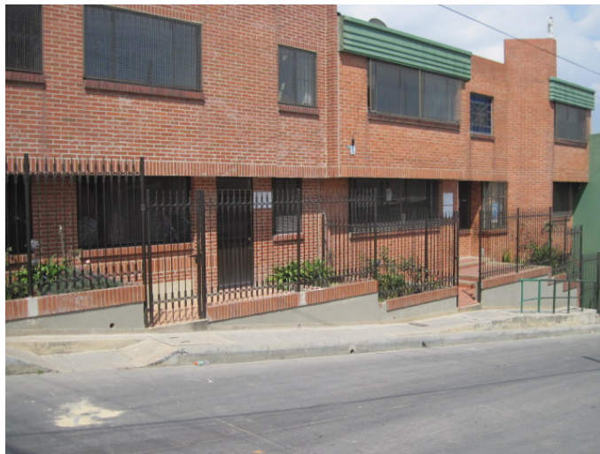
Fig. Nº 1 Frente exterior Obra Social Mornés
