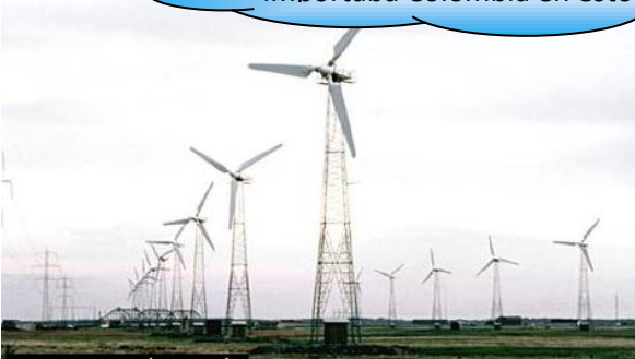
Turbinas de aire
