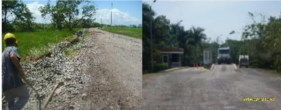
Ilustración 10. Detalle construcción vía interna y alumbrado de la vía interna (izq.) y báscula en la entrada al relleno sanitario PER.
