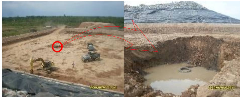
Ilustración 3. Nivel freático celda en construcción
