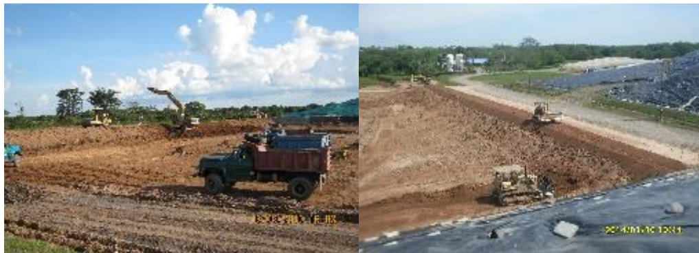
Ilustración 5. Construcción de diques en arcilla, para una celda de disposición final de residuos.
