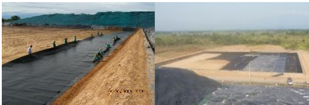
Ilustración 7. Proceso de impermeabilización
