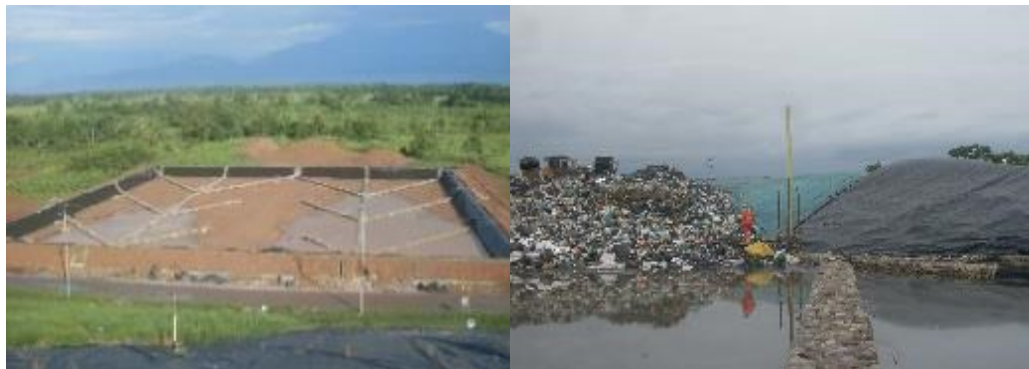
Ilustración 8. Sistema de drenaje de lixiviados y
