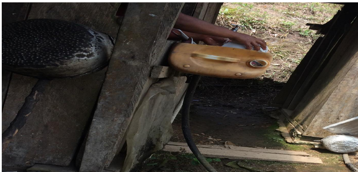
Figura 14. Agua Residual de Fregadero. Esta imagen pertenece al fregadero de una vivienda ubicada en la vereda El Cóndor la cual evidencia las condiciones de pobreza de la comunidad y la carencia de sistemas de tratamiento para las aguas residuales domésticas.
