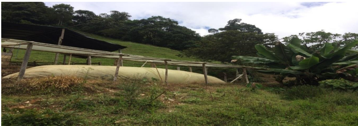
Figura 7. Biodigestor Familiar de Bajo Costo Implementado por el Proyecto REP. Esta imagen corresponde a un biodigestor de bajo costo implementado en la vereda el Rosal, corregimiento de la Gallera.
