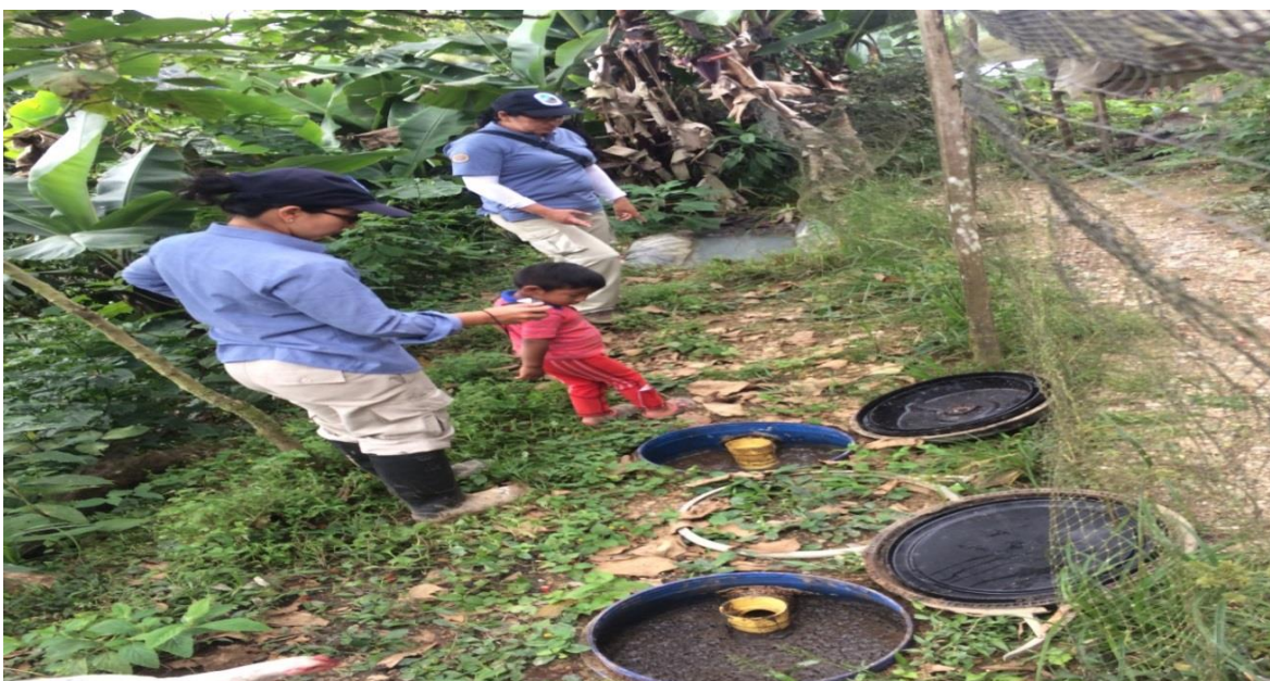
Figura 11. Trampas de Grasas Implementada por el Proyecto REP. Esta imagen corresponde a una trampa de grasas implementada en la vereda el Rosal, corregimiento de la Gallera.
