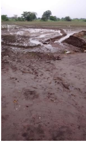
Adecuación del lote
