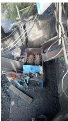
Fotografía No 3 Mantenimiento de mandíbula de trituradora
