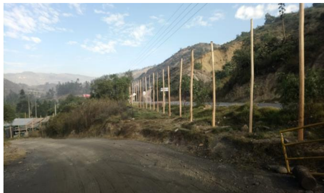
Fotografía No 1 Cambio de sistema de control perimetral para material particulado
