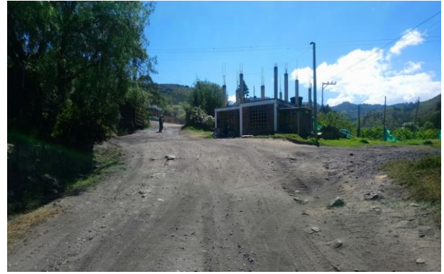
Fotografía No 8 Mantenimiento y afirmado de accesos viales del acopio
