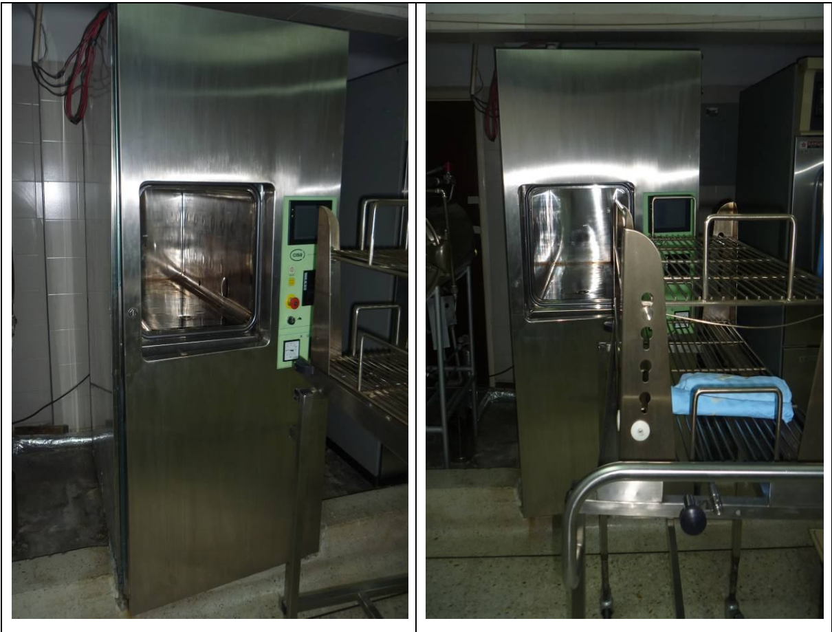
Figura No 6. Autoclave de 203 Lt, - CISA del Hospital Departamental Tomas Uribe Uribe E.S.E
