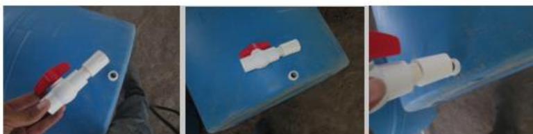
Foto N°2: Instalación de la llave de paso a la Caneca.
