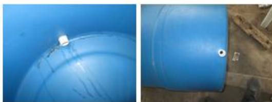
Foto N°1: Adecuación de la caneca de 55 galones.
