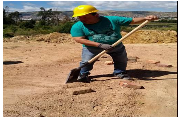
Alistado piso para la construcción de
