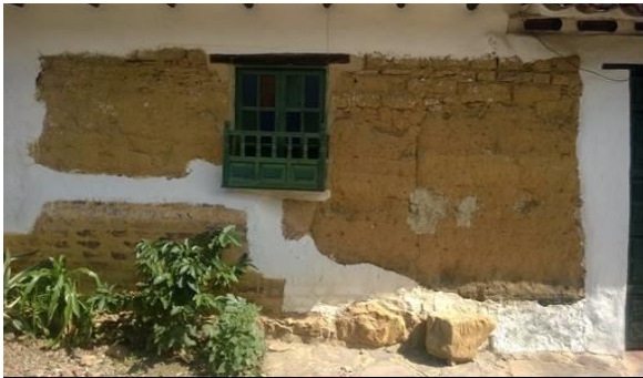
Vista construccion levantada en tapia pizada y adobe (villa de leyva).
