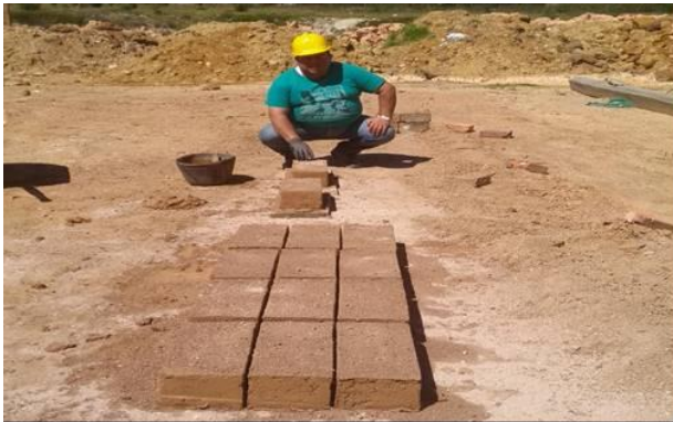
Adobe terminado para secado
