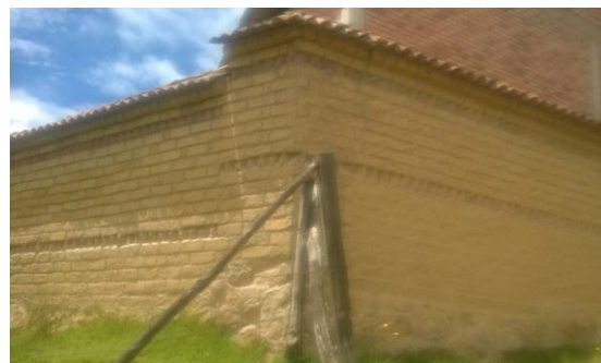
Cerramiento en Adobe Tunja
