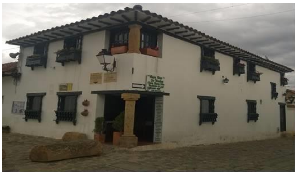
Construcciones en adobe (villa de Leyva).
