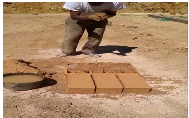
Construcción de Adobe con material de reciclaje
