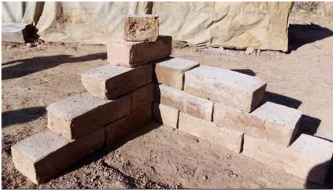
Vista construcción muro en Adobe en tolete trabado.
