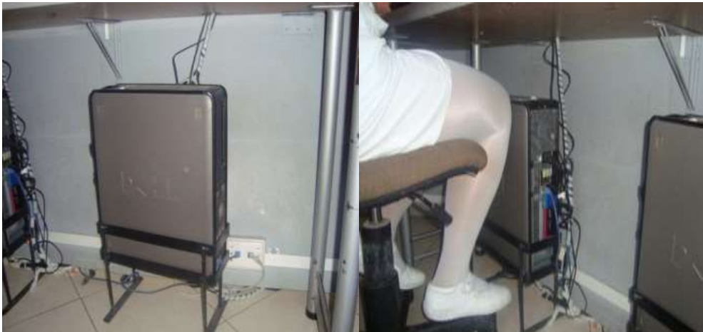
Figura 34. Ubicación inadecuada de equipos
