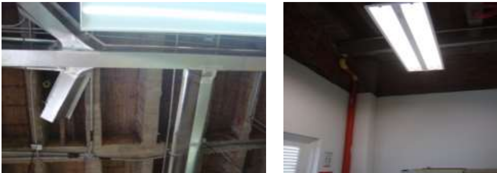
Figura 60. Tuberías subestación eléctrica UMI
