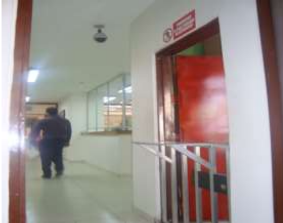
Figura 18. Entrada área de servidores
