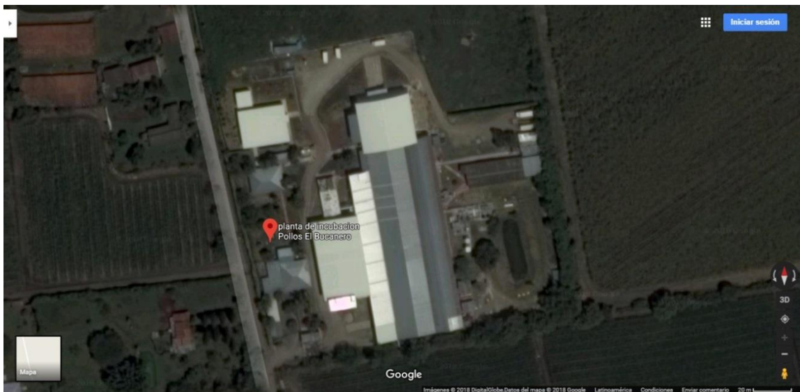
Figura 5. Toma Aérea de la Planta. Tomado de Google Maps Dic 2017.
