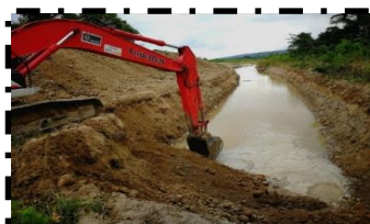
Figura 2 Canalización y construcción de
