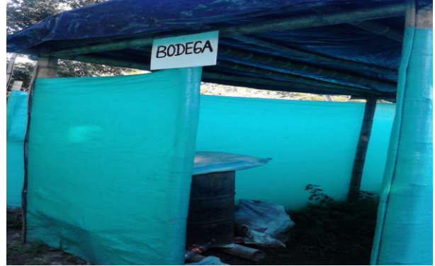
Ilustración 36. Señalización de la bodega
