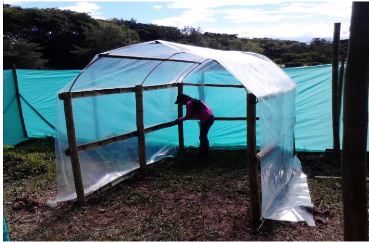
Ilustración 8. Adecuación de las instalaciones
