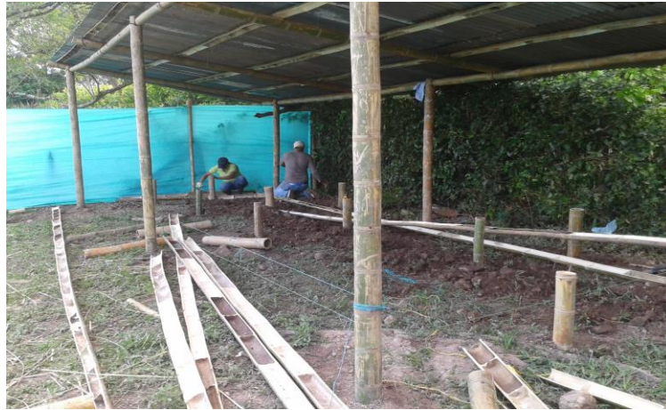
Ilustración 7. Construcción de las instalaciones
