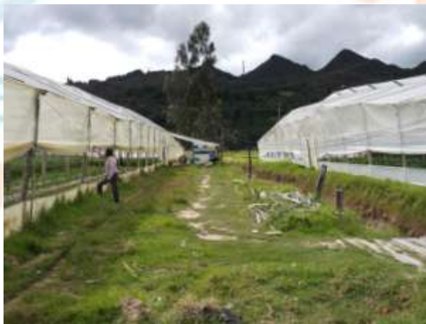
Fotografía 1. Invernadero Capilla simple y doble (Una o dos aguas) FUENTE: (Alvarado, Beltran, & Mateus)
