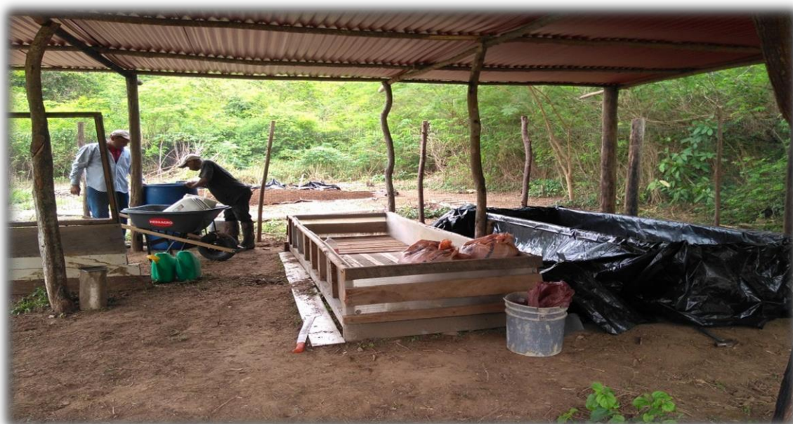
Figura 8. Cercado, techado y construcción de dos camas
