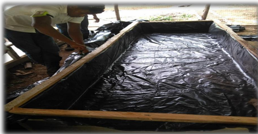
Figura 20. Recubrimiento con plástico en zona interna
