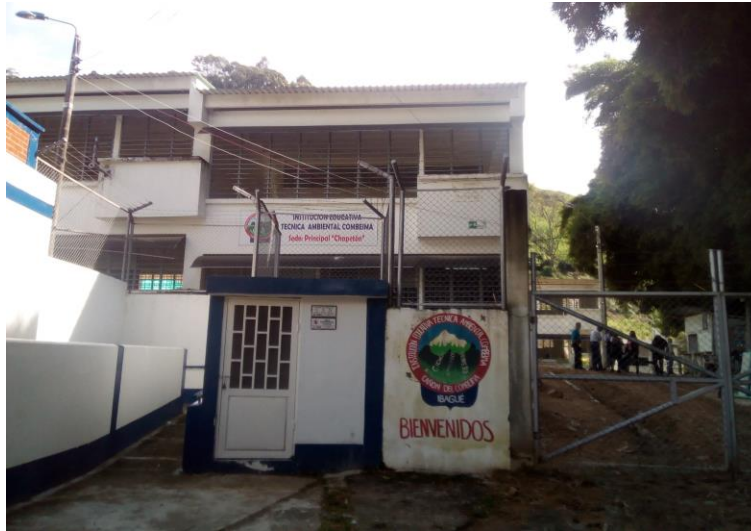
Fotografía n° 69 institución educativa técnica Ambiental Combeima.
