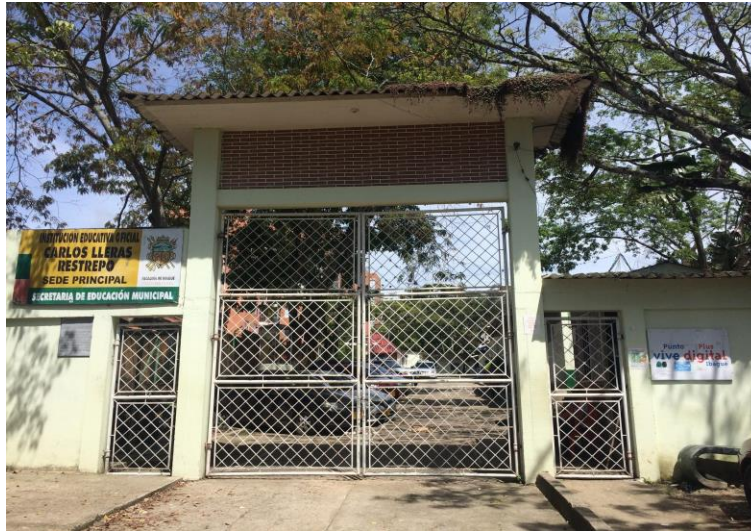
Fotografía n° 51 Institución Educativa Carlos Lleras Restrepo.
