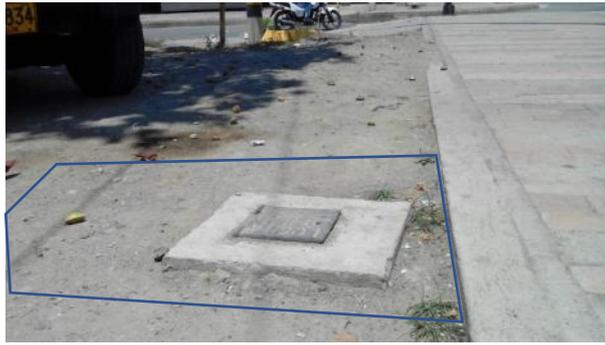
Ilustración 35. Válvula de sectorización para la instalación de macro de la ubicación #7 en tubería de Ø8" polietileno que viene directo desde el tanque alto de La Lucila hasta la Playa. Vista 1.
