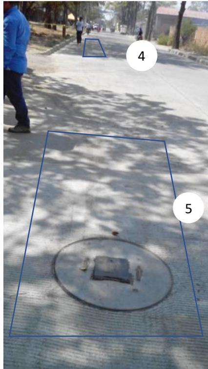
*Ilustración 31.* Ubicación de las dos cajas para los macros en tuberías de Ø8'' PVC de las ubicaciones 4 y 5, cerca al estadio, distancia entre válvulas de sectorización 15 m. Al frente poste de 12 m para medida, tablero PLC y enlace. Vista 1.
