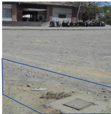
*Ilustración 24.* Ubicación de válvula sectorización en tubería de Ø3” polietileno a 1.2 metros aproximadamente de profundidad. “Ubicación #2” vista 1.
