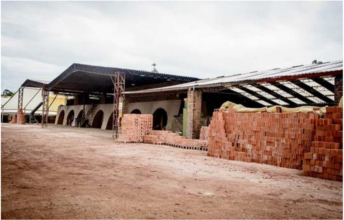
Ilustración 3. Dosificadores Aires Combustible para Horno Hoffman- Arcillas de Colombia
