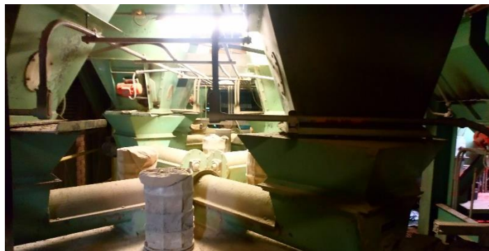
Figura 9. Tolvas de dosificación
