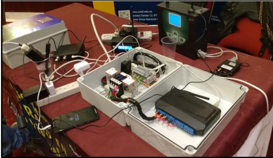
Figura 58→ Hardware estación base – sensores comunicación – Fuente: elaboración propia
