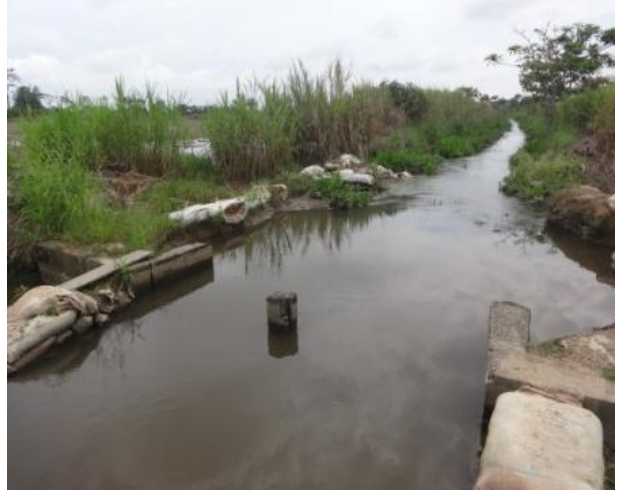
canal de riego.
