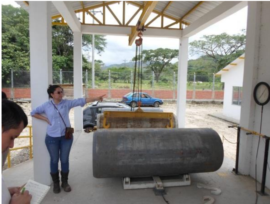
Figura 24. Cilindros de 900kg con cloro (Planta Modular)
