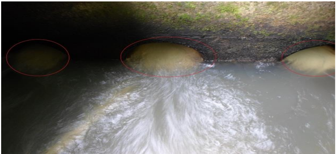
Figura 14. Líneas de 16" de acero al carbón. (Quebrada la Tablona)
