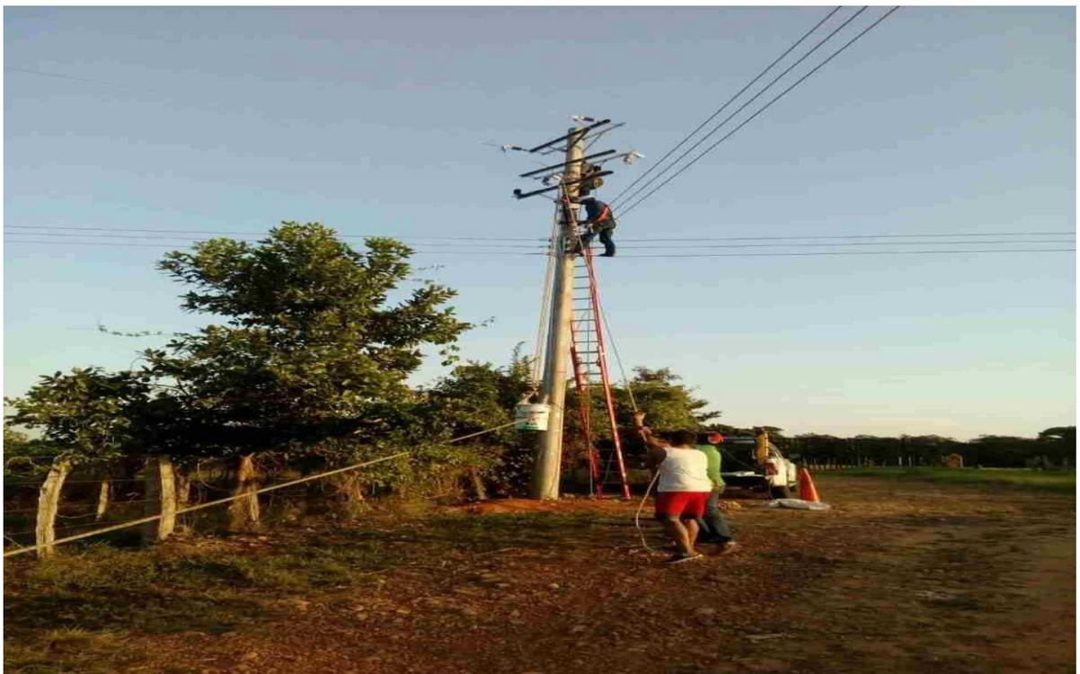
Foto 4. Tendido de cableado y montaje de transformadores
