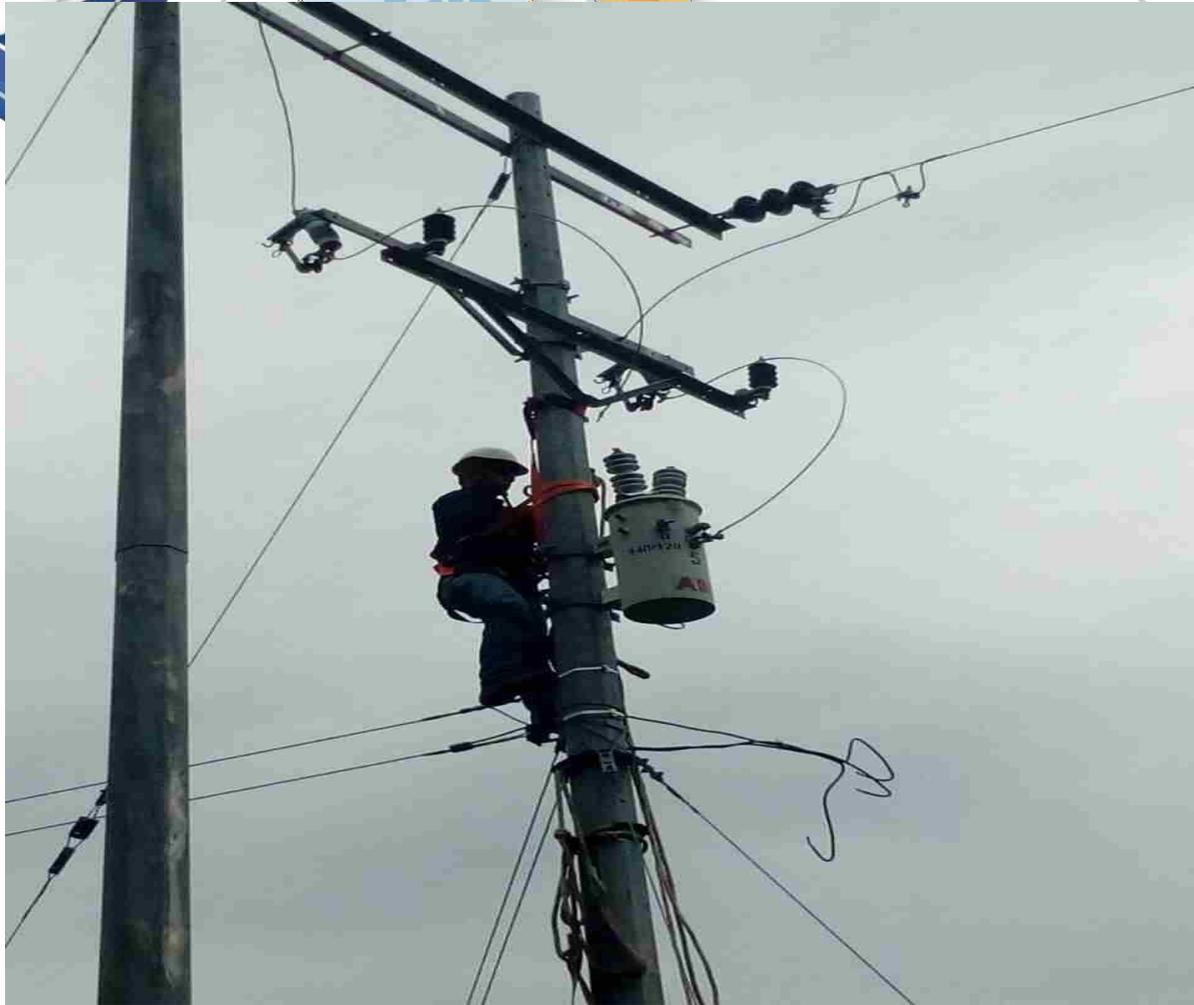
Foto 5. Conexión final de acometidas eléctricas
