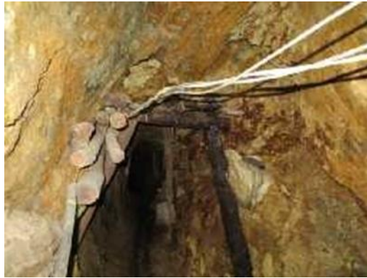
Figura 13. Sostenimiento de socavones mina la Gualconda
