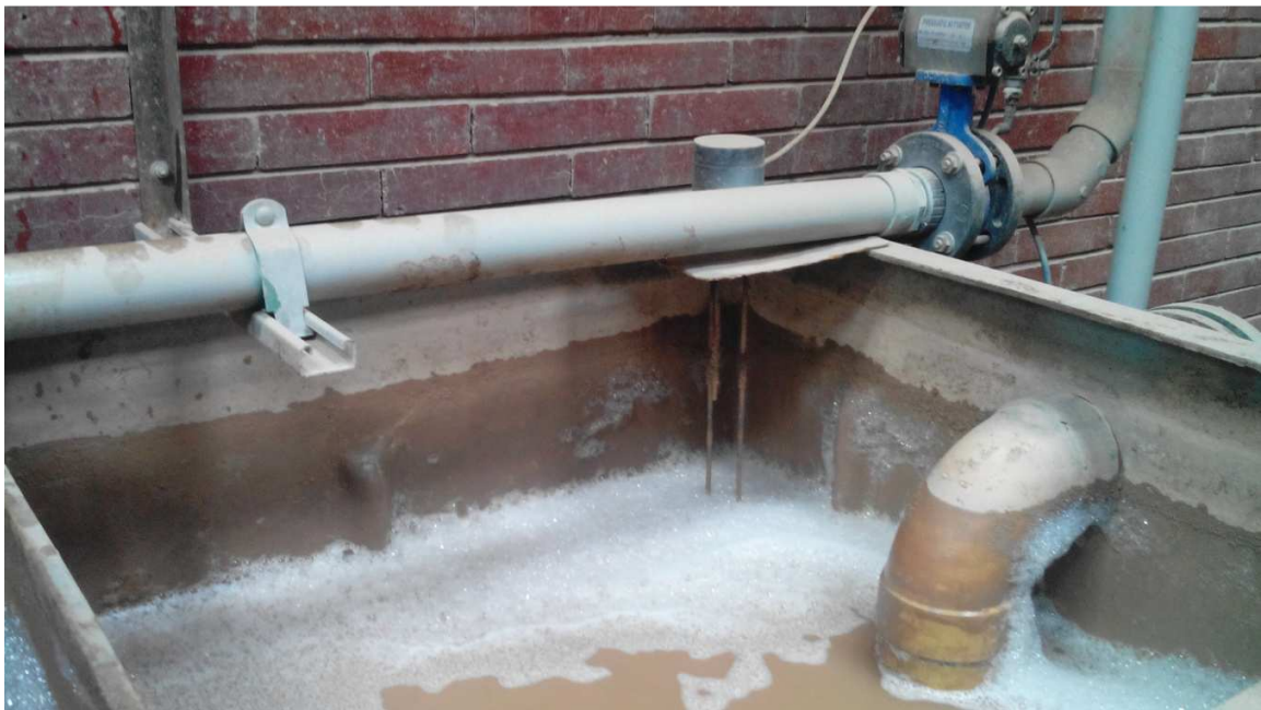
Imagen 16. Montaje sensor electroválvula
