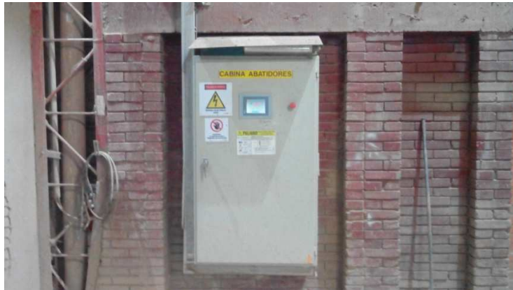
Imagen 51. Cabina control abatidores y dispersor parte externa
