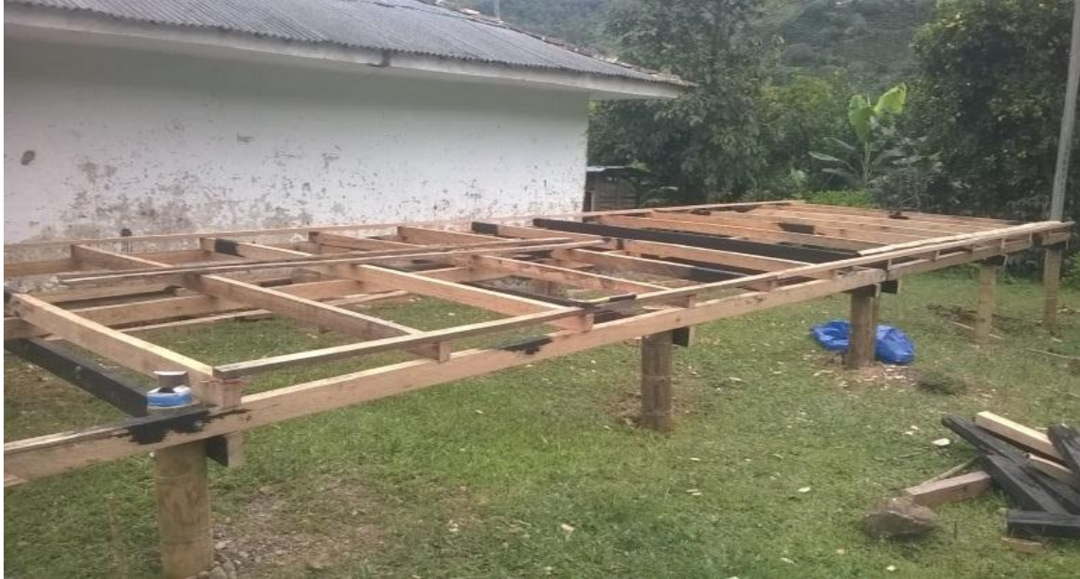
Ilustración 10. Seguimiento a la construcción de secadero parabólico finca El Guamito Fuente: Autoría propia
