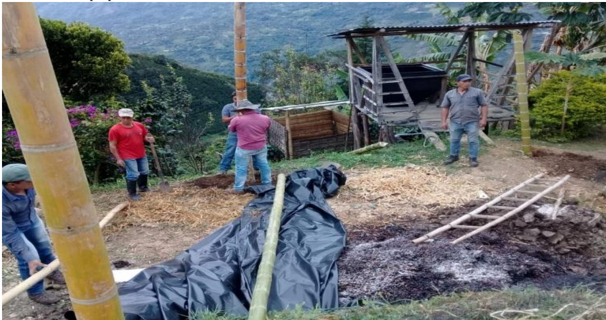
Ilustración 9. Verificación de materiales para la Instalación de composteras Fuente: Autoría propia
