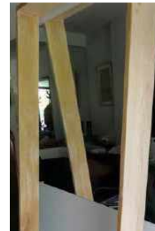
Estructura de la obra, madera en proceso de lijado y pulido.
