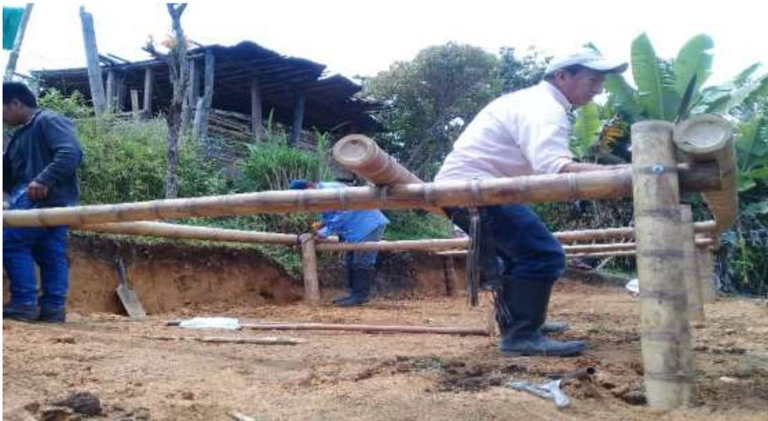
*Ilustración 4:* Guaduas de 3 Metros Instaladas Sobre Marcos
