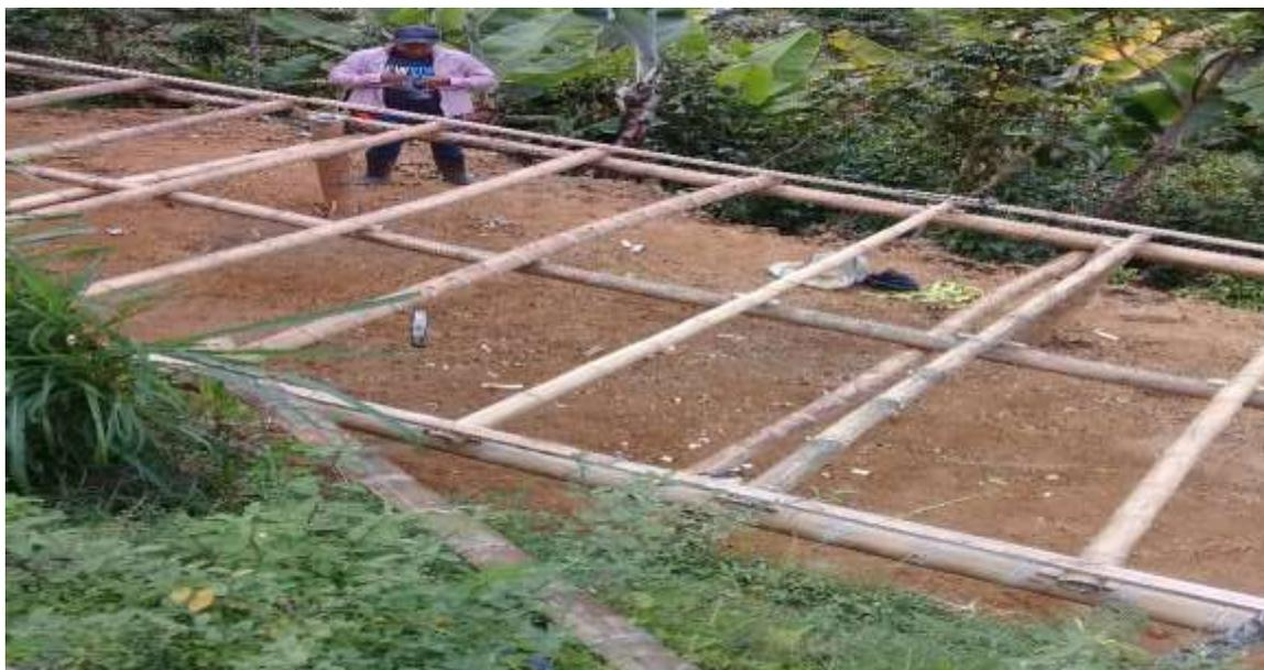
*Ilustración 8:* vigas de guadua 3 metros instaladas encima de las guaduas de 9 metros
