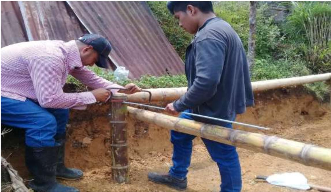
*Ilustración 2: Viga Sujetada con Tornillo de 3/8.*
