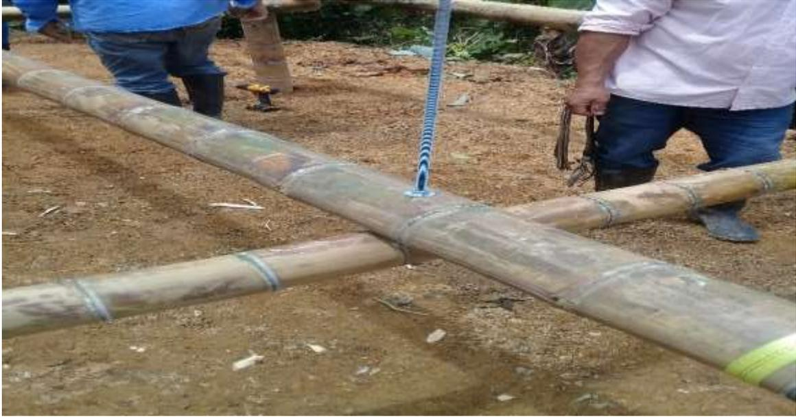
*Ilustración 6* : Asegurar todas las guaduas con tornillos en diferentes puntos
