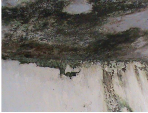
Imagen 2. Pared y loza Primer Piso, Patio 5.
