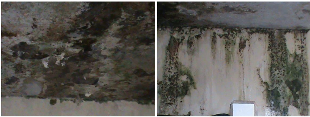
Imagen 3. Pared y loza Segundo Piso. Patio 5.
