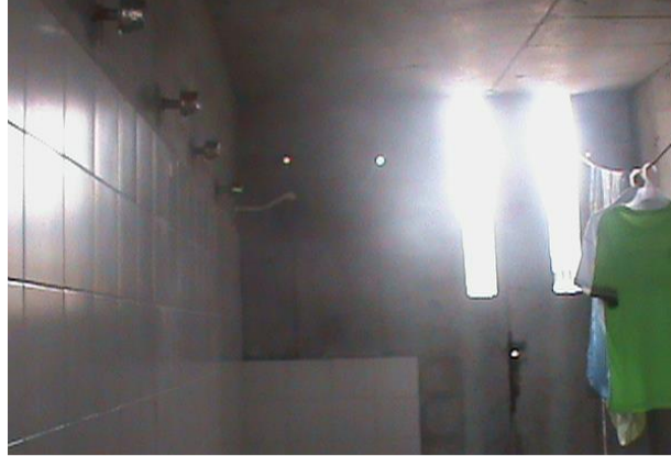
Imagen 7. Duchas Oriente Segundo Piso Nuevo Patio 5
