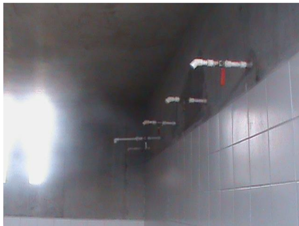
Imagen 9. Arreglo duchas Nuevo Patio 5
