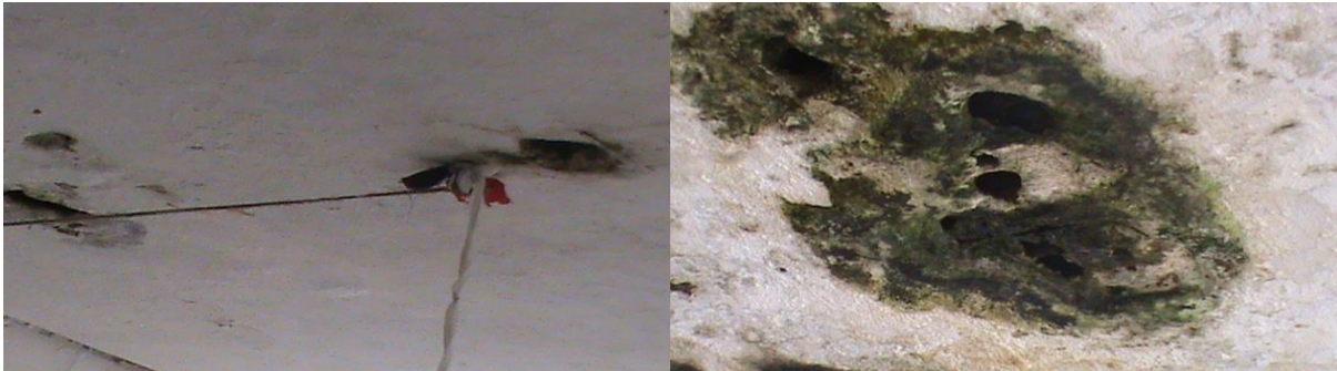
Imagen 4. Loza Tercer Piso. Patio 5
