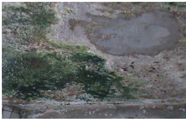
Imagen 6. Techo Capilla Patio 5
