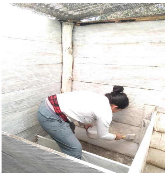
Fuente: autoría propia Anexo 17. Adecuación de instalaciones
